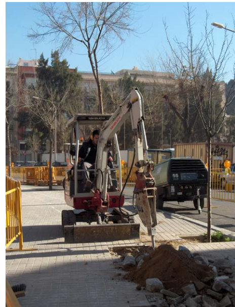
FOTO 4. Inici de la rasa 1
