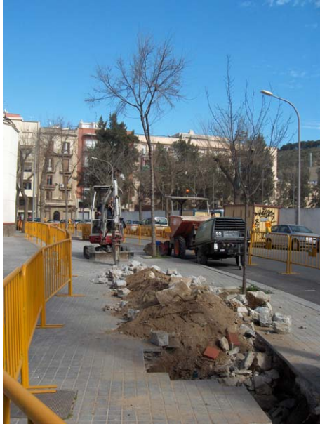
FOTO 5. Inici de la rasa 1
